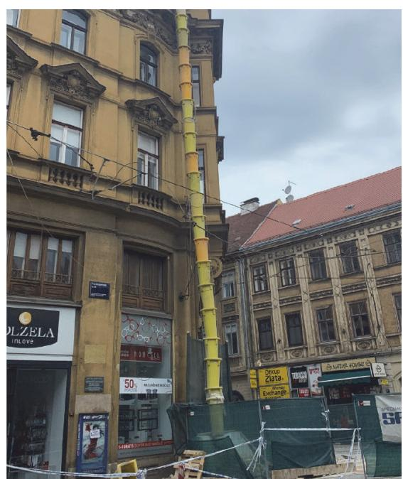
Slika 102. Razgradnja oštećenoga zidanog zida
