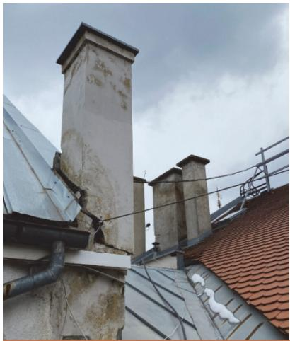
Slika 8. Teška oštećenja (slom) dijelova dimnjaka iznad krovne konstrukcije
