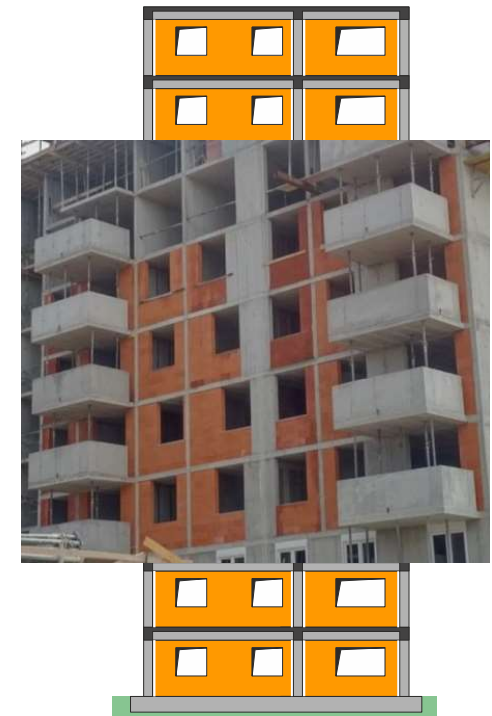
A-b zgrada s ispunskim zidom
