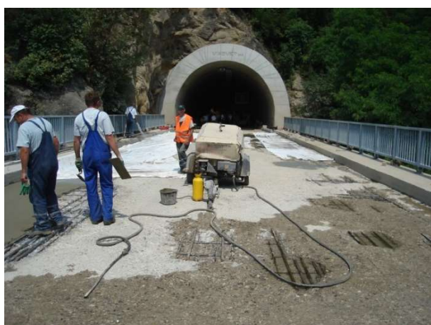
Sanacija ploha epoksi mortom
