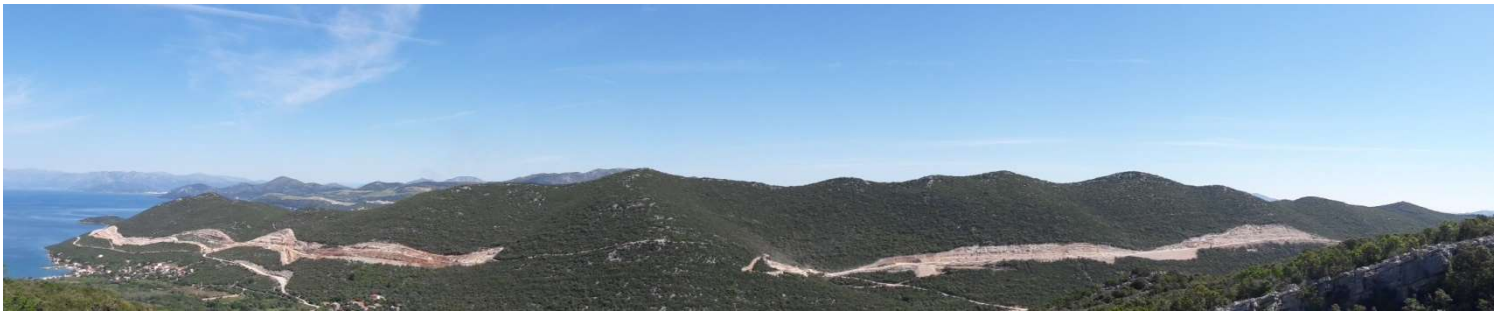
Trasa - svibanj 2021 od km 5+600 do km 7+600
