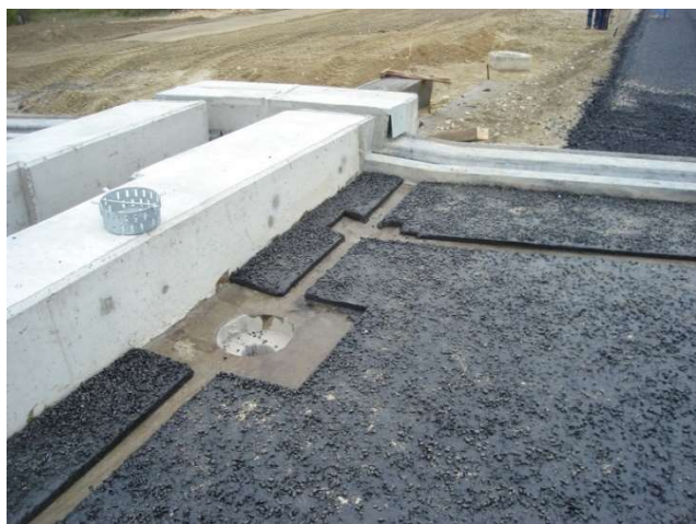
Izvedeni kontra padovi, kanali u lijevanom asfaltu i cjevčice za odvodnju uz dilataciju.
