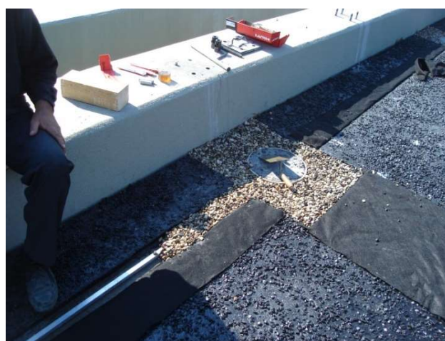
Ugrađen jednozrnat epoksidni šupljikavi beton, pocinčana perforirana cijev i geotekstil
