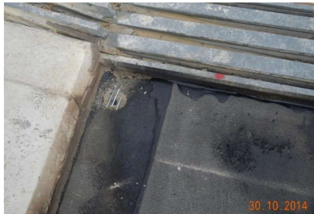
Cijevčica za odvodnju na kraju dilatacije
