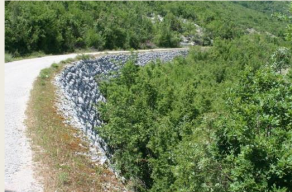
Podzid željezničke pruge
