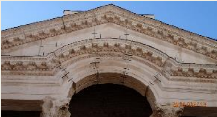
Metalne klamfe na konstrukciji Protirona u Splitu
