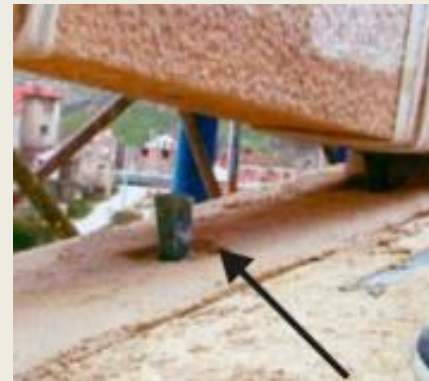
Čelični trnovi na konstrukciji Starog mosta u Mostaru
