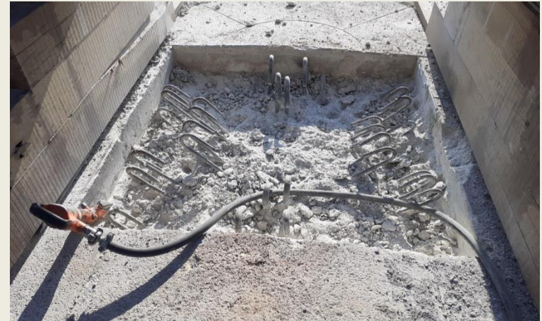
Uklonjen ležaj na stupu S4 i ležajni kvadar; Ostavljena armatura za spoj sa novom armaturom
