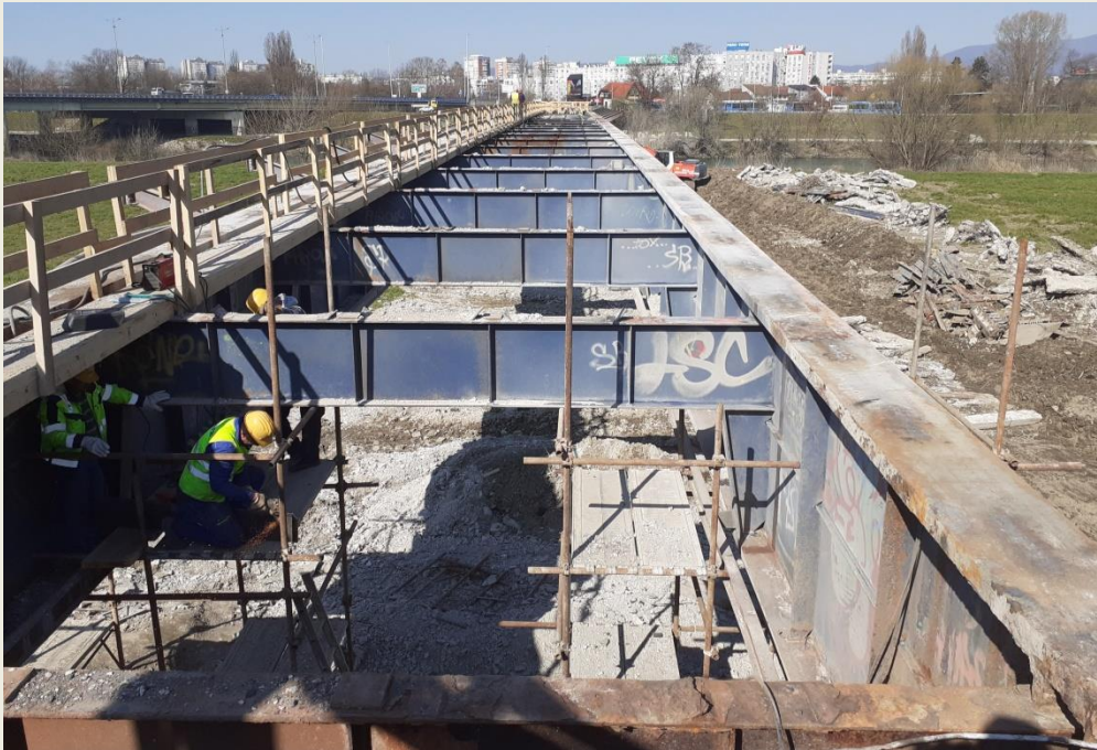
01.03.2021. - Uklonjena AB konstrukcija, sekundarni uzdužni nosači, konzole i vijenci
