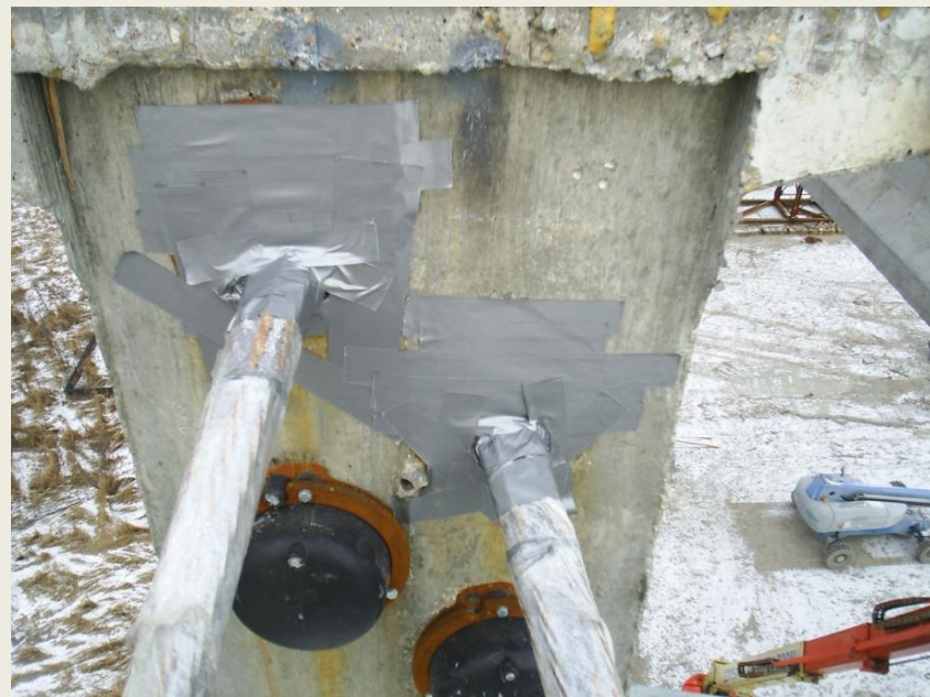
MCI 309 – zaštita PT kablova prije injektiranja
