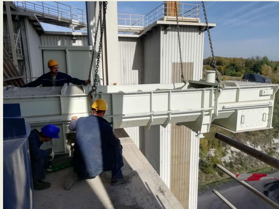
Montaža elemenata postrojenja RDF na izmjenjivaču topline....
