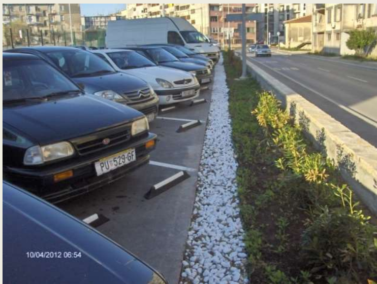
Graničnici umjesto rubnjaka na parkiralištu i infiltracijski jarak - Pula
