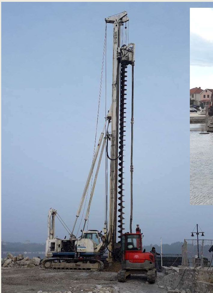
Izvedba AB pilota metodom CFA
