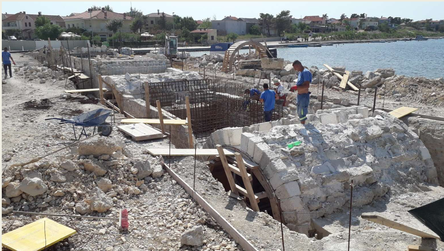
Donji most, građevna jama kroz faze gradnje
