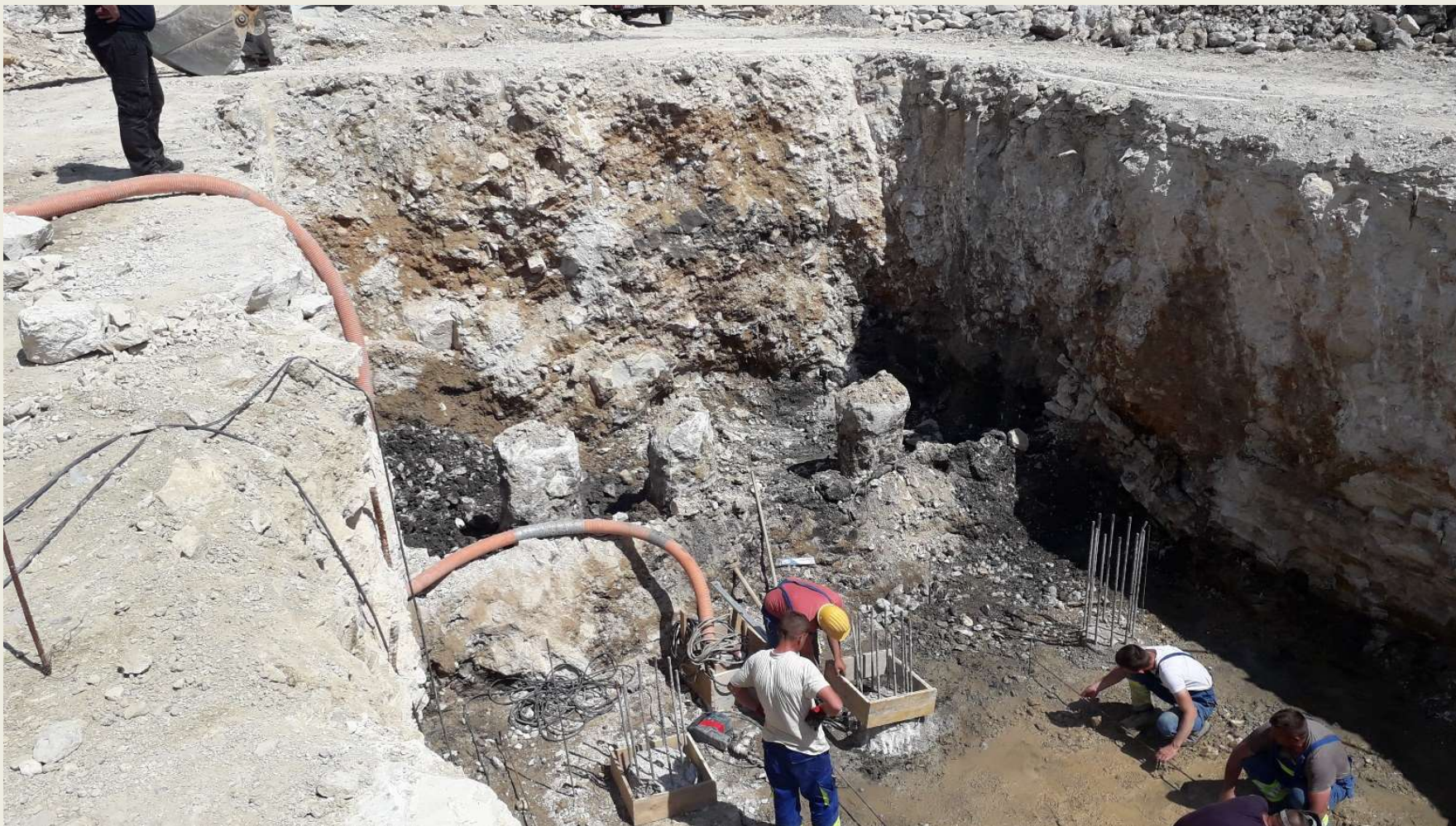
Gornji most, građevna jama kroz faze gradnje
