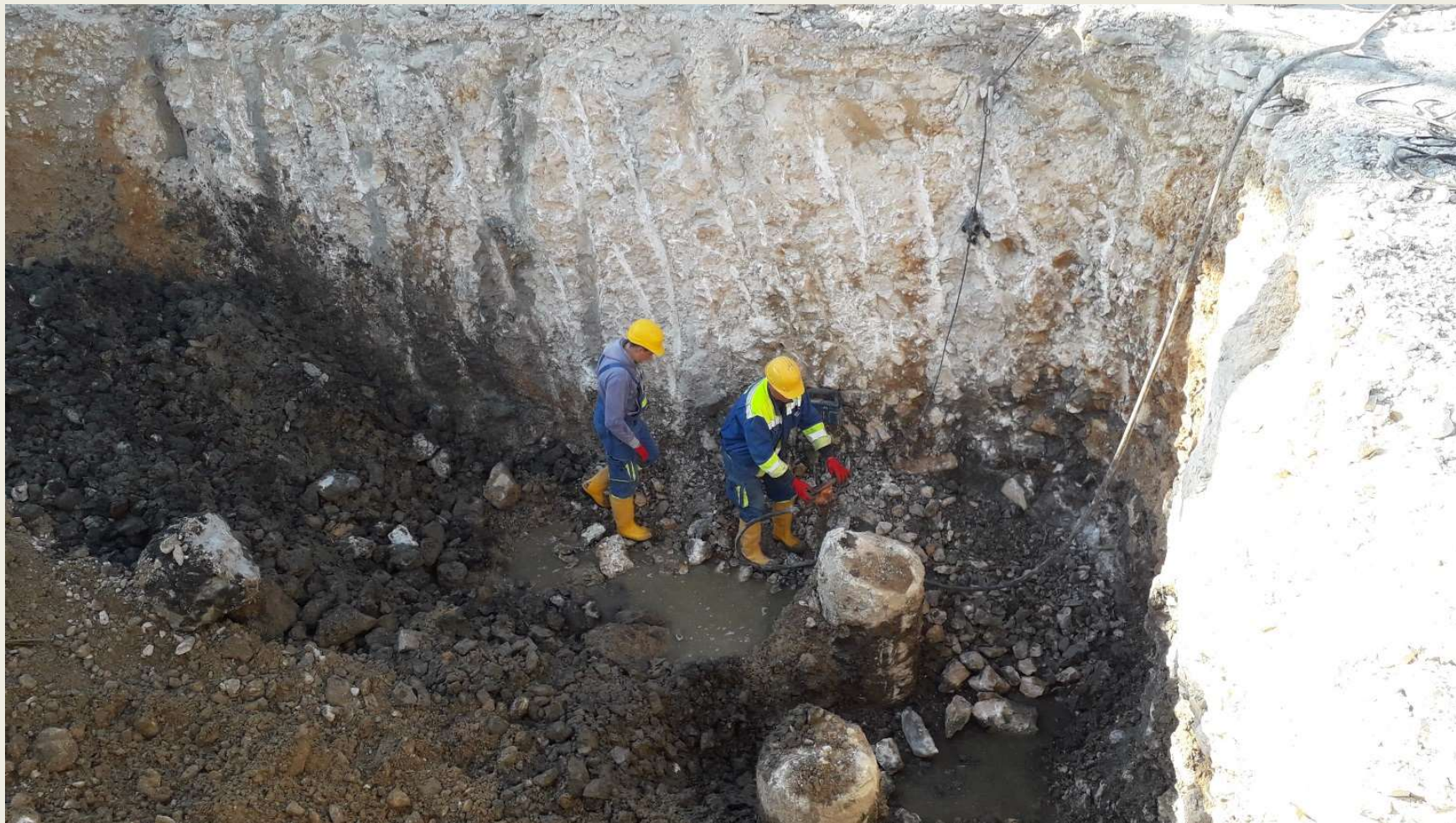
Donji most, građevna jama kroz faze gradnje
