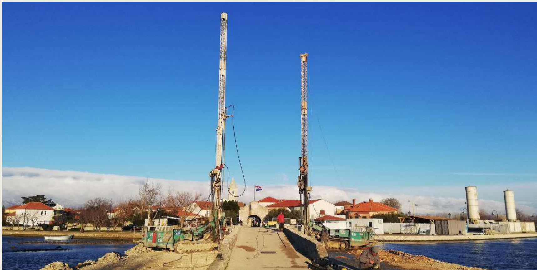
Donji most, ojačanje tla mlaznim stupnjacima
