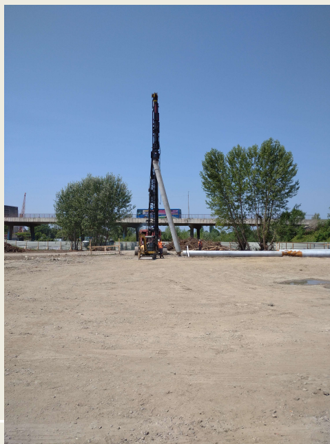
Prikaz ugradnje pilota Sisak
