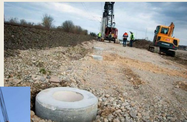
Ugrađeni prefabricirani piloti
