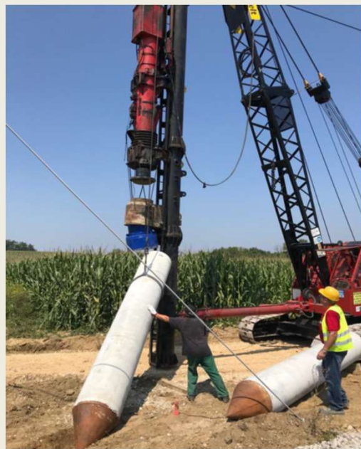
Opasivanje pilota sajlom i podizanje
