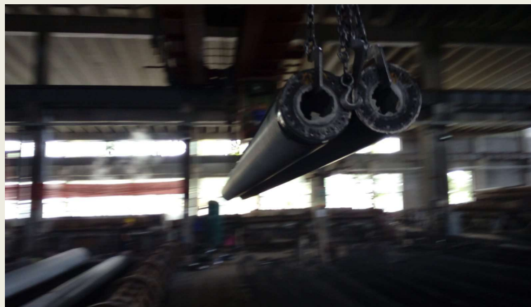
Prikaz tvorničkog transporta gotovog pilota do predviđenog skladišta
