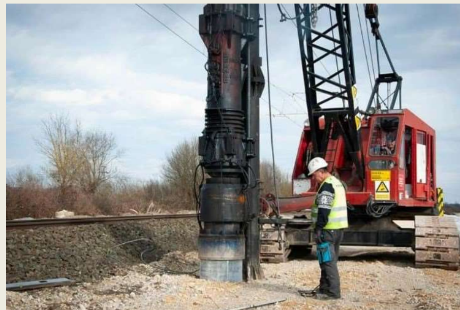
Prikaz ugradnje pilota; Dugo Selo-Križevci
