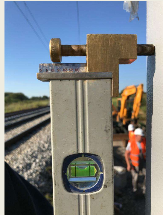
Kontrola vertikalnosti pilota
