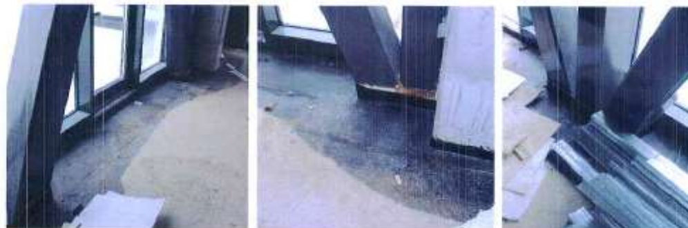
Fotografije 2.5 do 2.7 - Mjesta repera 1 do 7 u osi "I" prekrivenih hidroizolacijom
