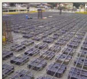
⑥ Pauza od 45 / 60 min između 1. faze i 2. faze betoniranja
