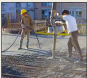
⑦ 2. faza betoniranja
