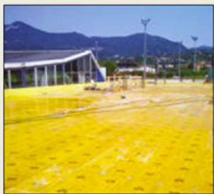
① Postavljanje oplata
