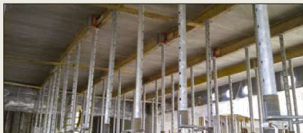
⑧ Skidanje oplata
