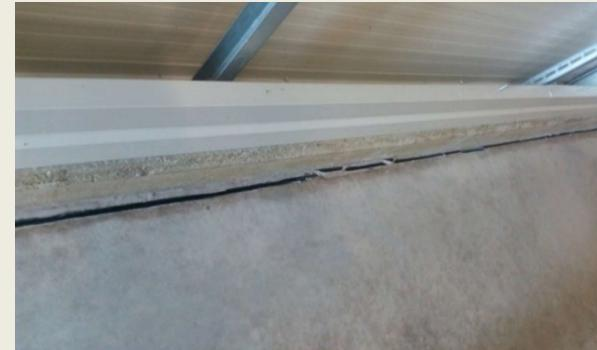
Evidentno je da je tijekom vremena došlo do skupljanja betona ( uslijed same prirodne pojave skupljanja betona, te skupljanja od dodatnog podnog zagrijavanja betonske ploče) te su se radne reške povećale, čak do otvora veličine cca 40 mm, što je vrlo nepovoljno jer sva voda i nepoželjni materijal, može ući između, te na taj način doći direktno u samu strukturu betonskog poda.
