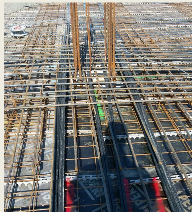
Ploča uoči betonaže, postavljena armatura i kabeli
