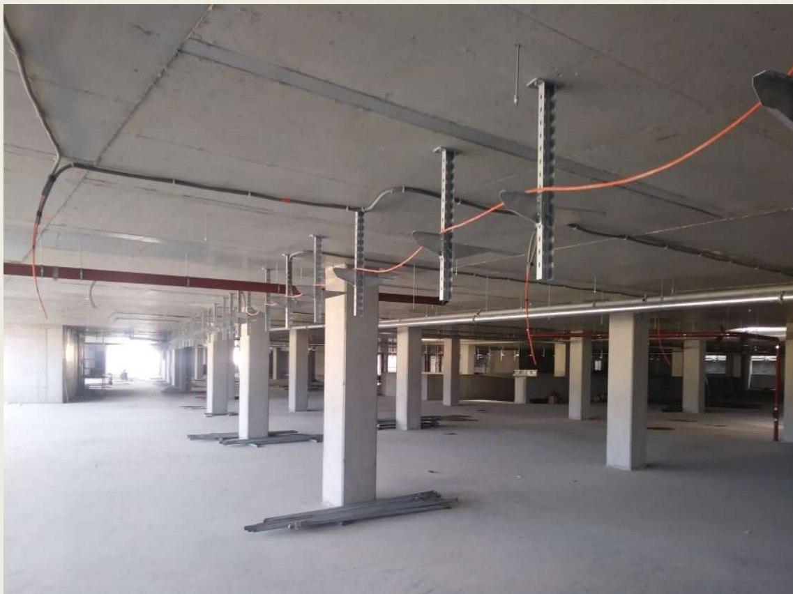
Pogled dijela ploče nakon skidanja oplata, faza postavljanja instalacija
