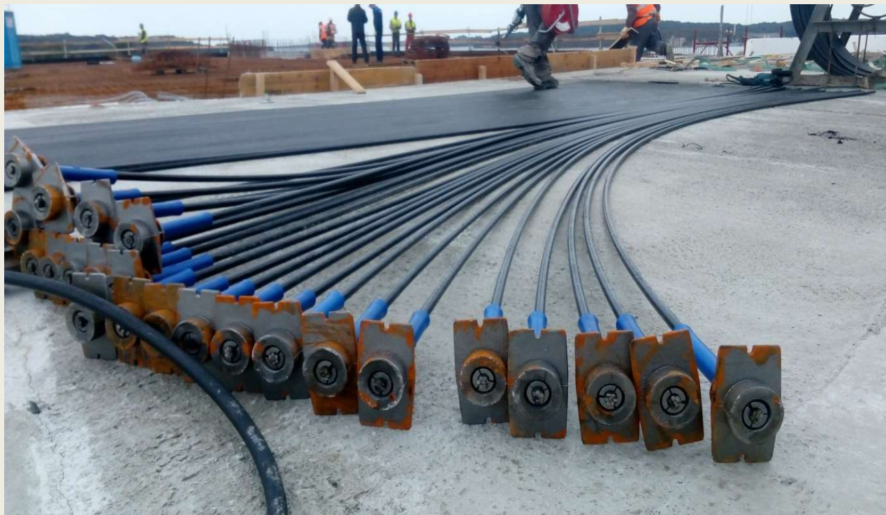
Kabeli sa usidrenjima - anker pločama (gradilište „Max Stoja“)
