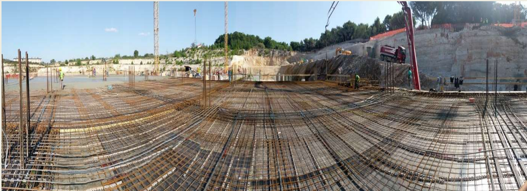
Panoramski prikaz betoniranja segmenta PT ploče
