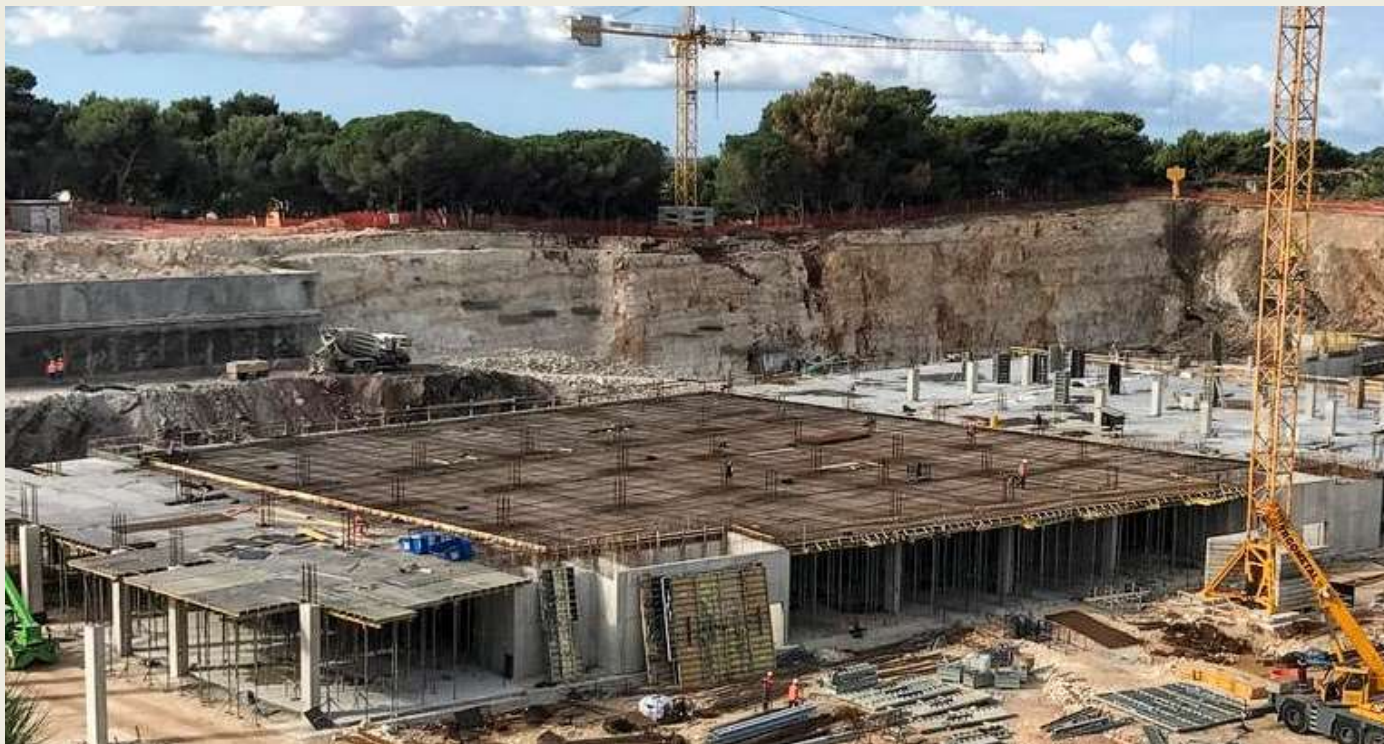
Prva prednapeta ploča na gradilištu "Max Stoja"
