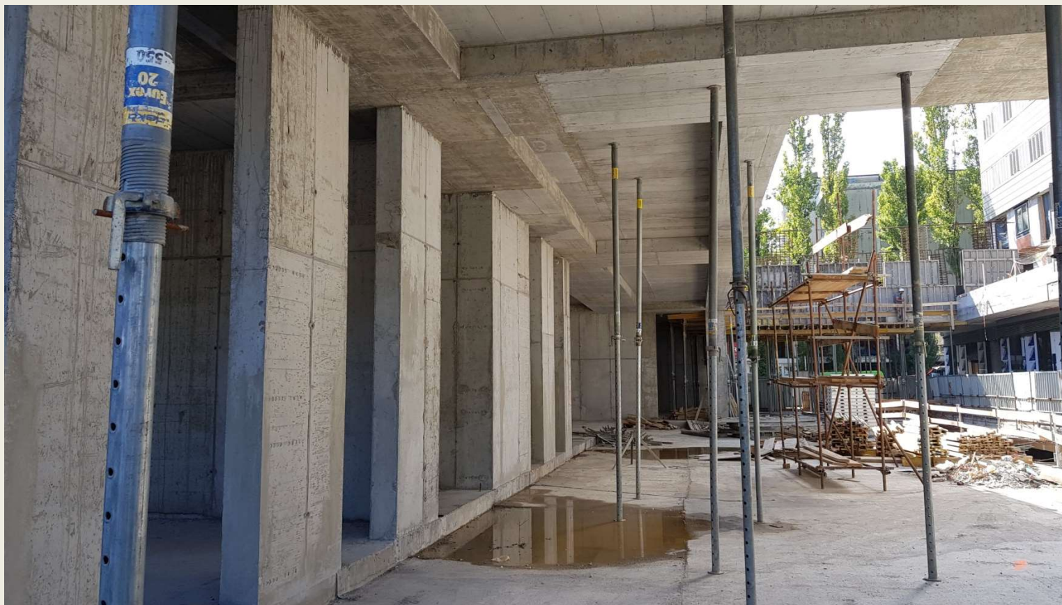
Pogled na konzolu južnog dijela i izgradnju spojnog mosta prema zapadu
