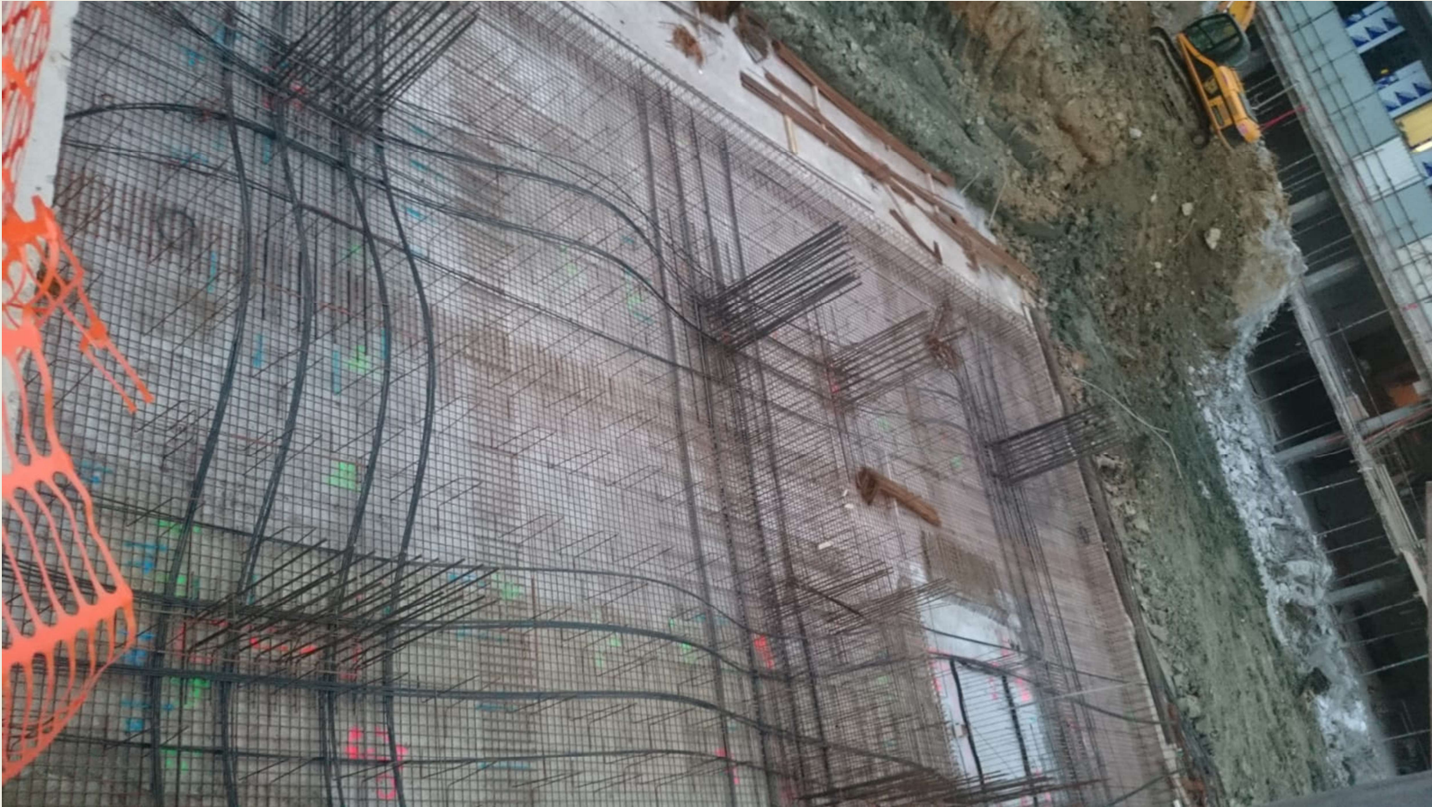
Početak izvedbe temelja južnog dijela zgrade, vidljiv podrum sjevernog dijela
