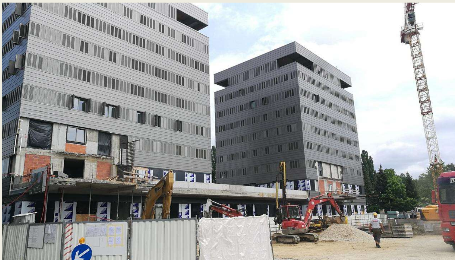
Sjeverni dio zgrade završen, vidljiva mjesta ostavljena za spoj konstrukcije
