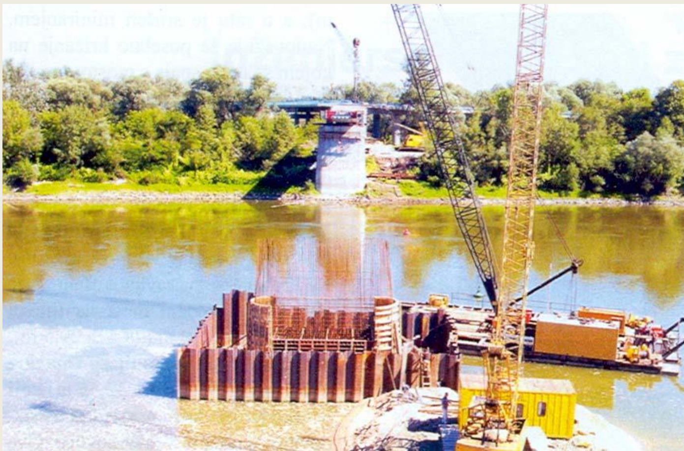
Sanacija stupa S7, radovi tijekom 2005.
