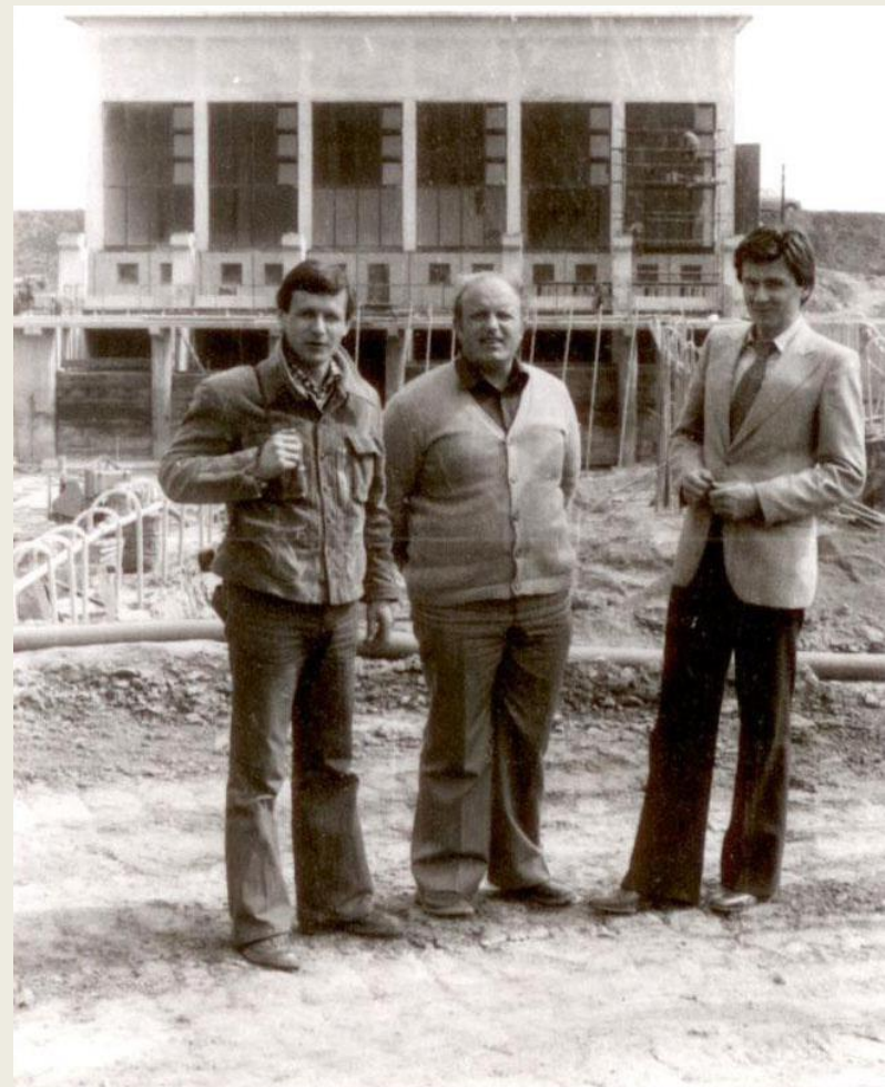
Crpna stanica Migalovci, 1979.
