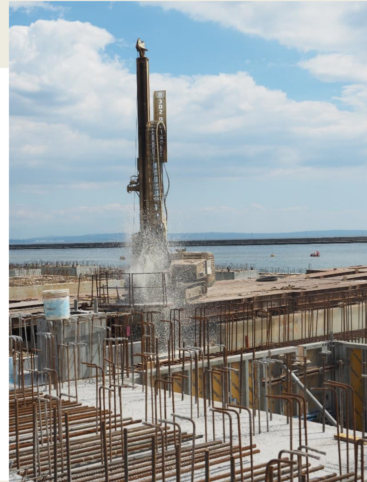
IZRADA STUPNJAKA MLAZNIM BETONOM KROZ KESON
