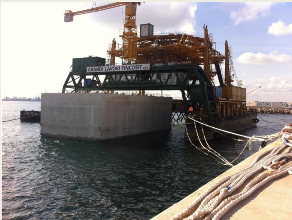
„TVORNICA KESONA” – KATAMARAN BENEDETTA IZLAZAK KESONA 5c
