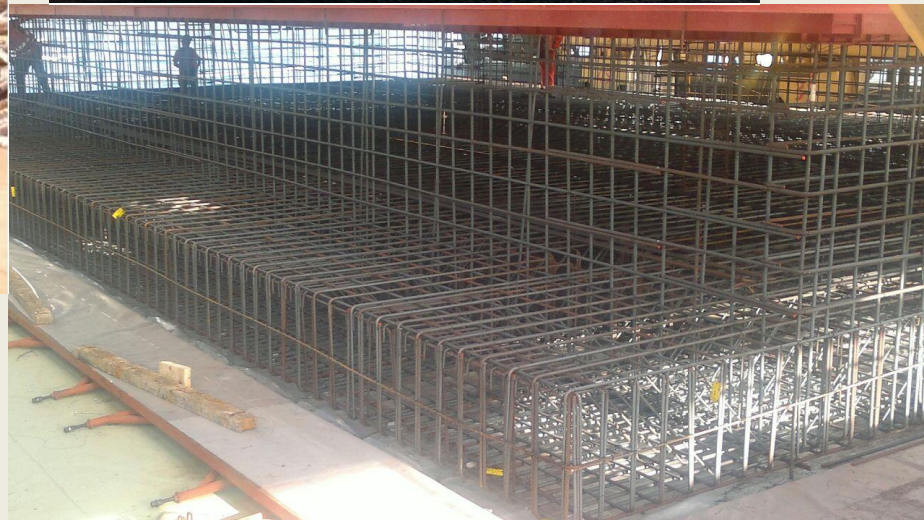
ARMATURA DONJE PLOČE KESONA
