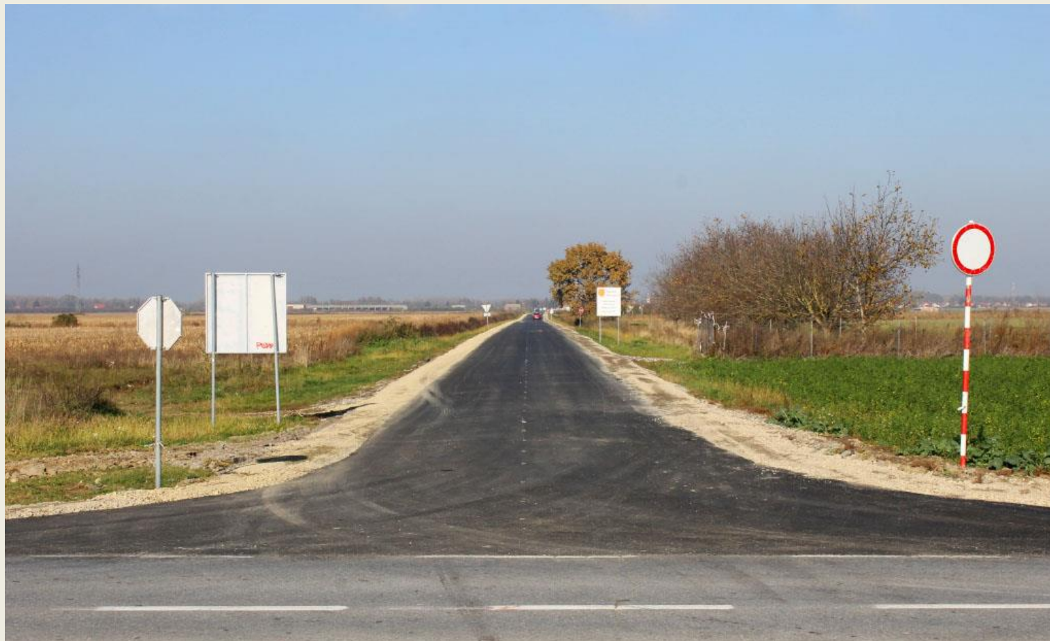
Lokalna cesta nakon sanacije nosive konstrukcije i kolnika
