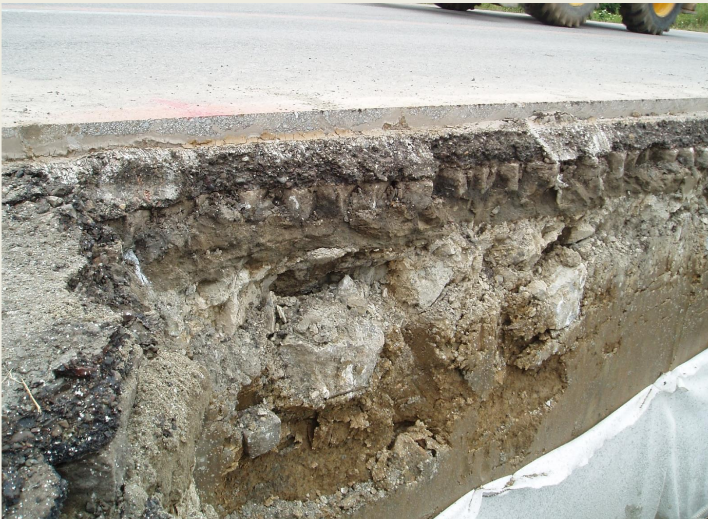
Poprečni presjek stare autoceste Zagreb - Beograd
