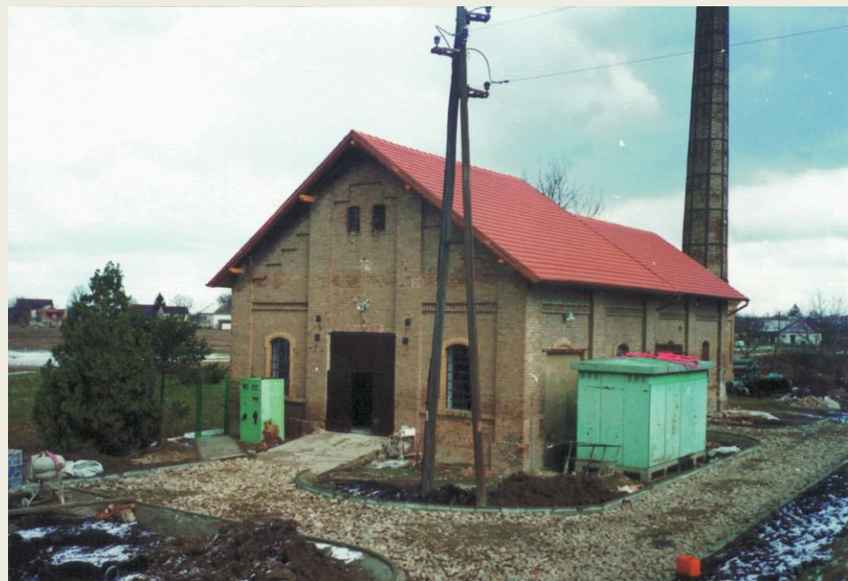
2.5. Obnovljena crpna stanica „Draž”, 2000.g.
