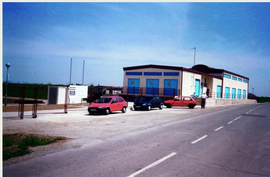
2.15. Obnovljena crpna stanica „Paulin Dvor“, 2002.g.
