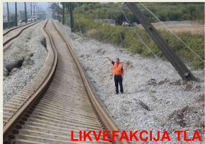
OŠTEĆENJE DONJEG I GORNJEG USTROJA
