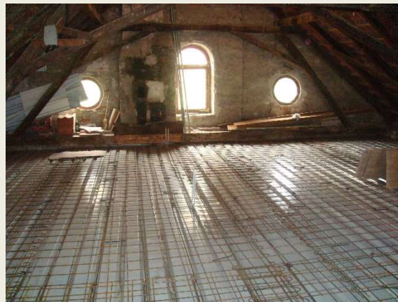
Spregnuta ploča čelik - beton
