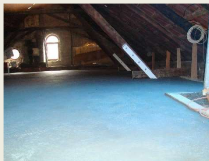
Spregnuta ploča čelik - beton
