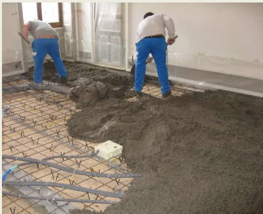
Spregnuta ploča drvo - beton
