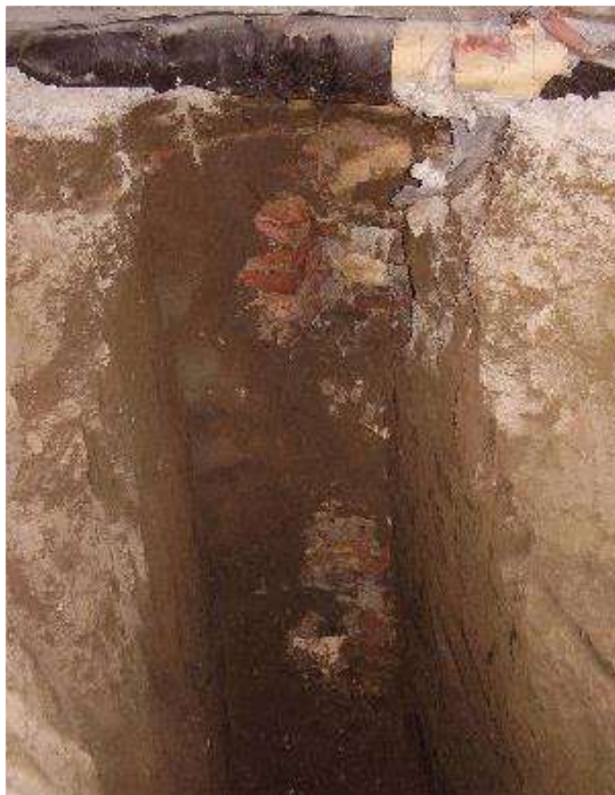
Sondažna jama uz temelj zida
